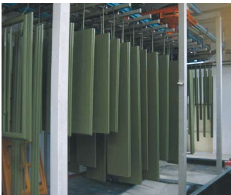
6 - Il tunnel d'asciugatura: il trasportatore aereo tri-rotaria consente di disporre le bilancelle in accumulo trasversale a 45° o a 90°. 6 – The drying tunnel: the three-rail overhead conveyor (Power & Free) allows for the availability of the racks in transversal accumulation, at 45° or 90°.
